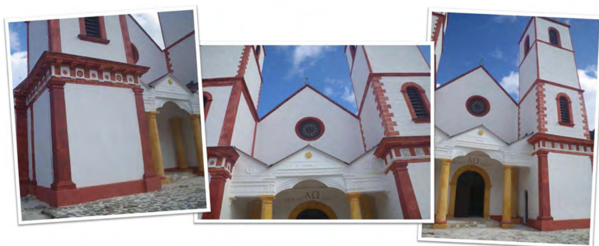
Restauration de l'entrée principale terminée
